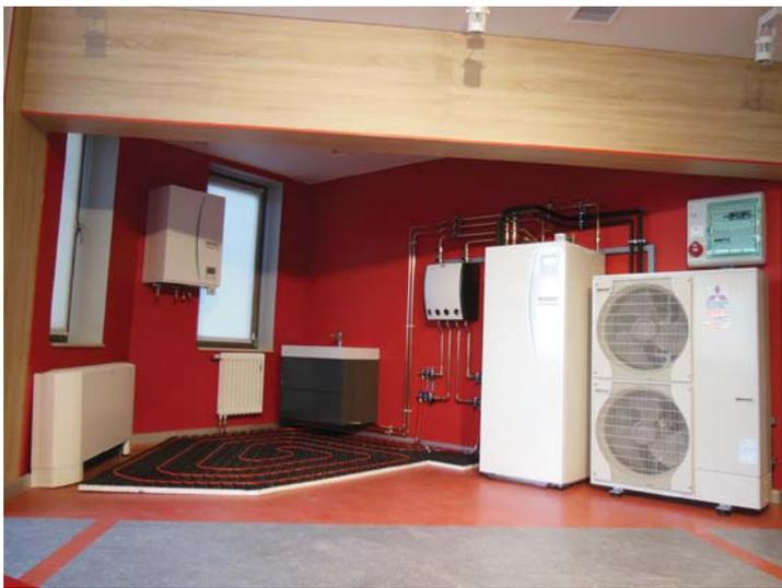
СИСТЕМА ОТОПЛЕНИЯ И ГВС «ECODAN» С ТЕПЛОМЫМ НАСОСОМ «ZUBADAN»
